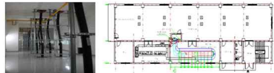
<그림 2> 기설 케이블처리실(좌), 1층 케이블처리실 평면도(우)
